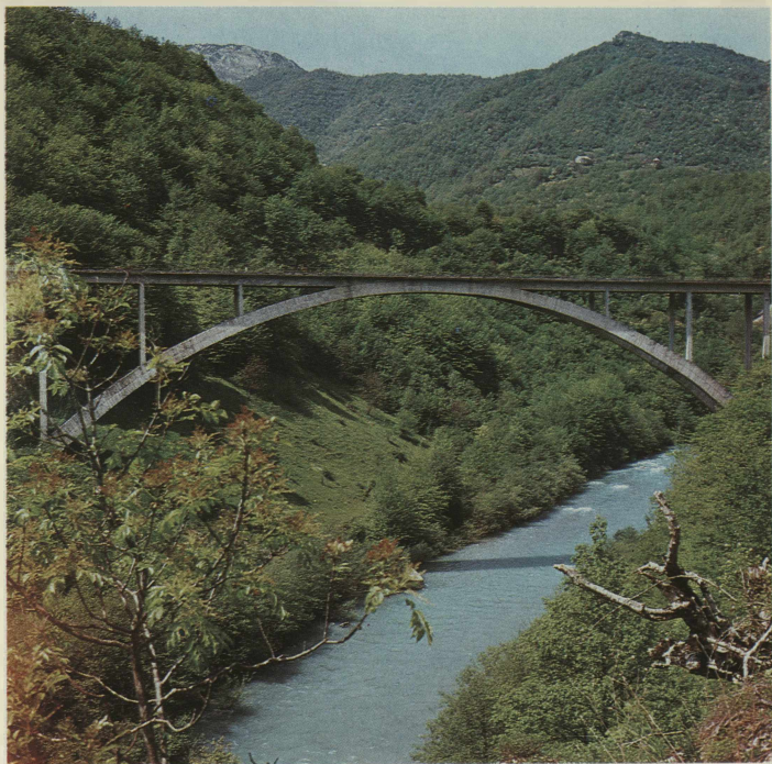
МОСТ „ПЈЕНАВАЦ“ НА МОРАЧИ
