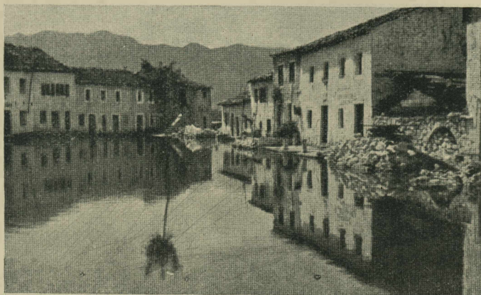
Strasse im Dorf Rijeka bei Hochwasser.
