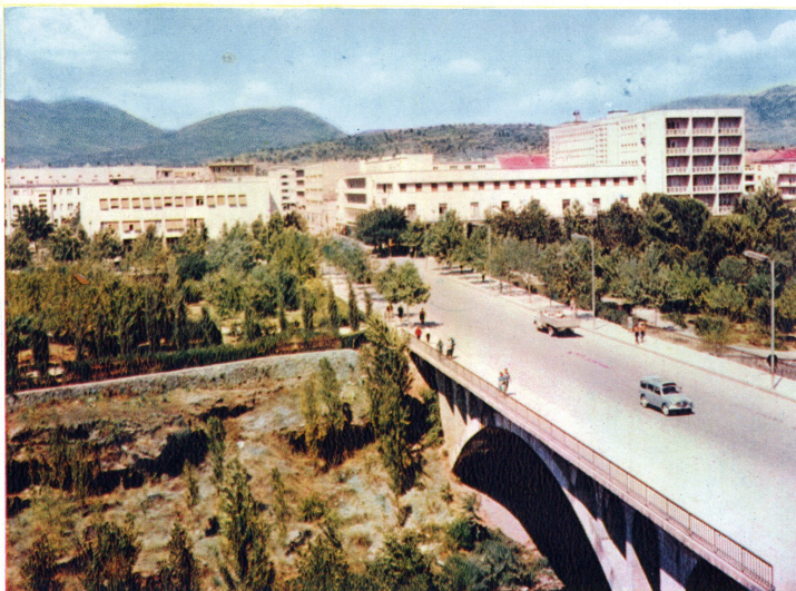
MOST NA RIBNICI — BRIDGE OVER THE RIBNICA RIVER — PONT SUR LA RIBNICA — BRICKE ÜBER DIE RIBNICA
