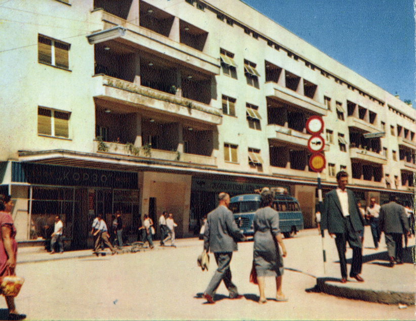
GLAVNA ULICA - POSLOVNICA JAT-A — MAIN STREET - THE JAT OFFICES — RUE PRINCIPALE - OFFICE DU JAT — HAUPTSTRASSE - GESCHÄFTSSTELLE VON JAT
